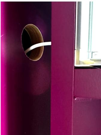
Stromkabel durch das Loch in den Sockel führen und dort mit Verlängerungskabel verbinden.
