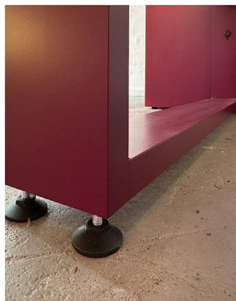
Der Rahmen wird mithilfe höhenverstellbarer Schraubfüße ausgerichtet.
