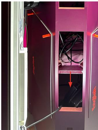
Der Stecker des Leuchtrahmens wird in die 10er-Steckerleiste in der Medienstele gesteckt.
