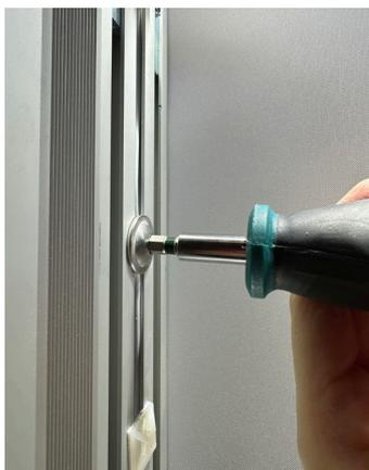
Die obere Schraube mit Inbus H6 festziehen. Für die untere Schraube wird kein Werkzeug benötigt.
